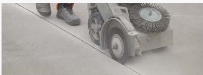
Szczotka do spoin stosowana w budownictwie drogowym
